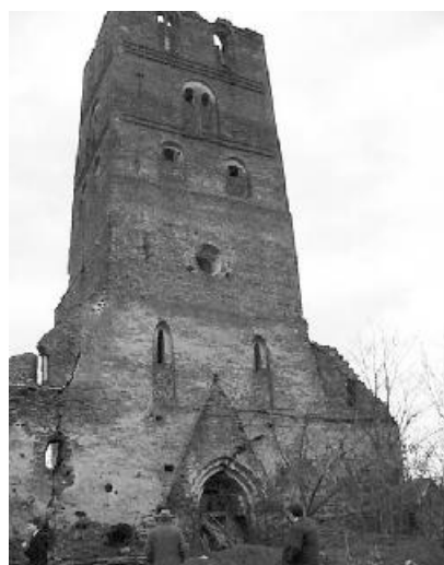
A hatalmas épület Türkösi Róza néni telkén áll, de állami tulajdonban van. Ez akadályozza a felújítását
